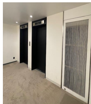
エレベーターホール
