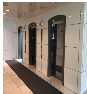
エレベーターホール
