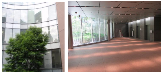
地上1階エレベーターホール
