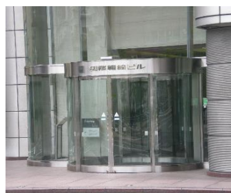
エントランス外観
