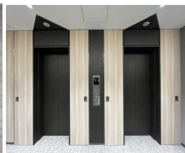
エレベーターホール
